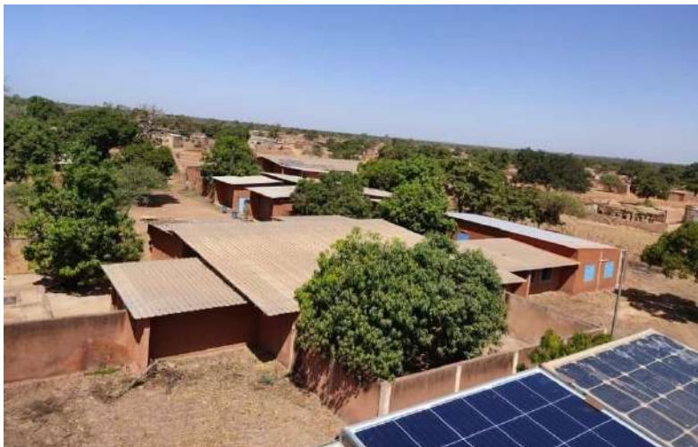
Le foyer Pogbi vu depuis le toit du château d'eau
