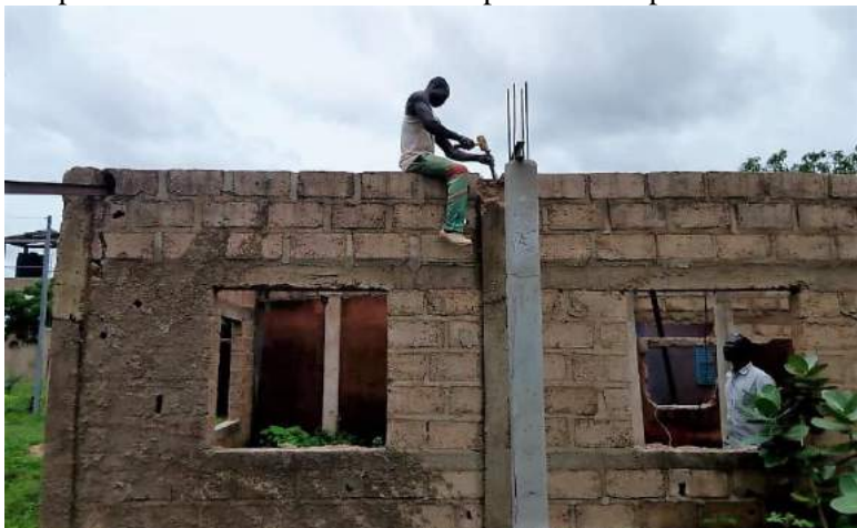
Pose des IPN pour le toit du réfectoire
