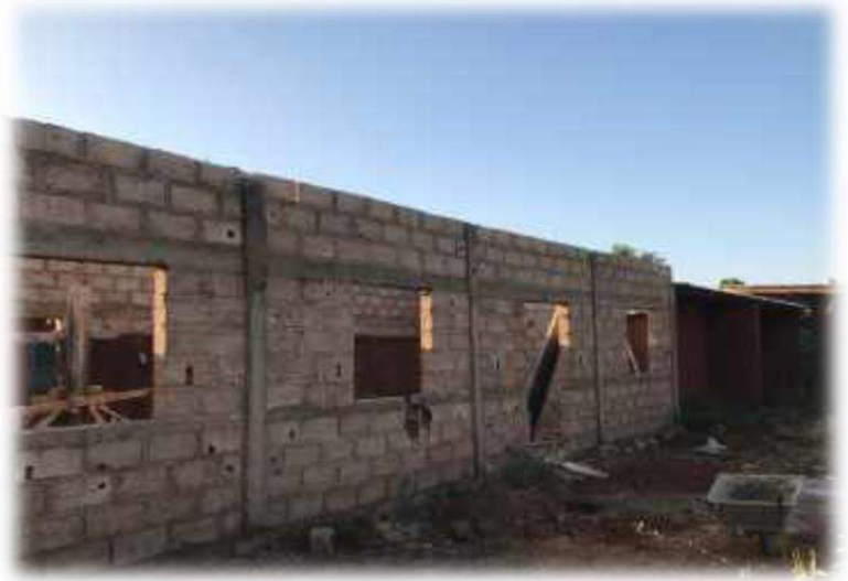
Le réfectoire en construction
