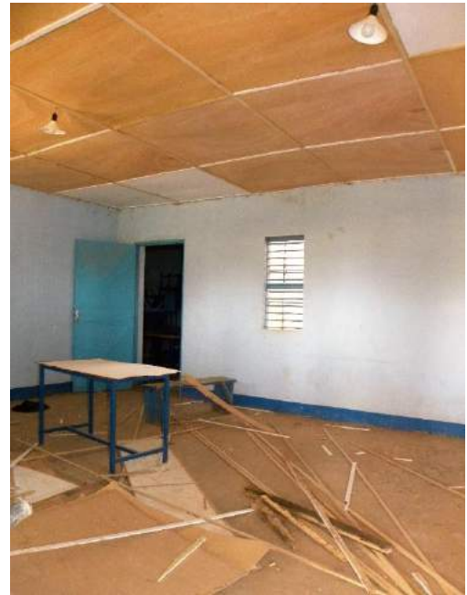
Réfection des plafonds
